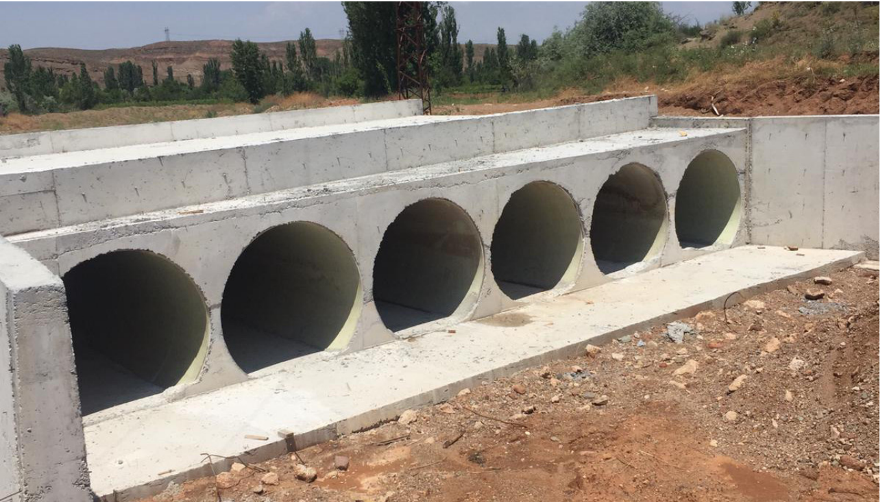
Merkez Karadayı Menfez Yapımı
