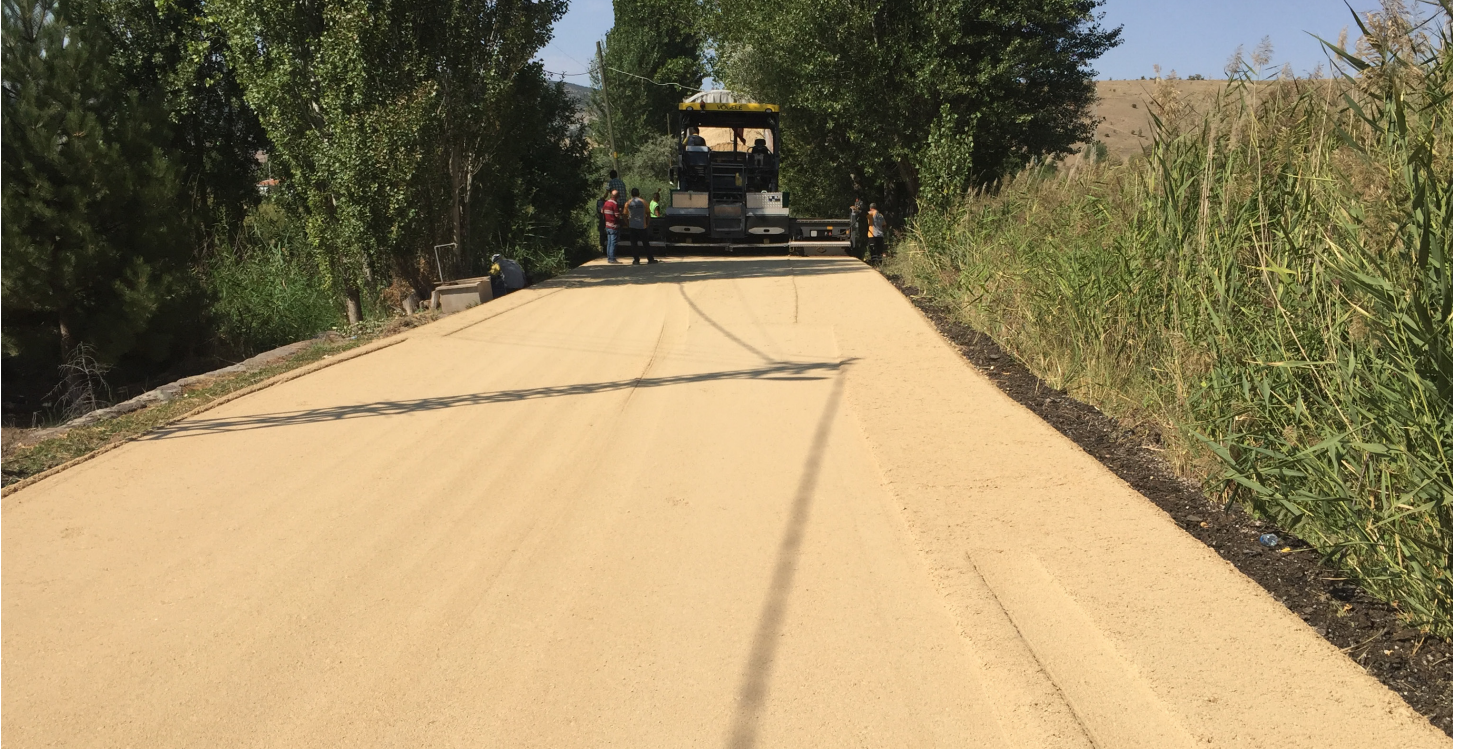
Merkez İlçe Aşağıçavuş Köyü Sıcak Asfalt (BSK)
