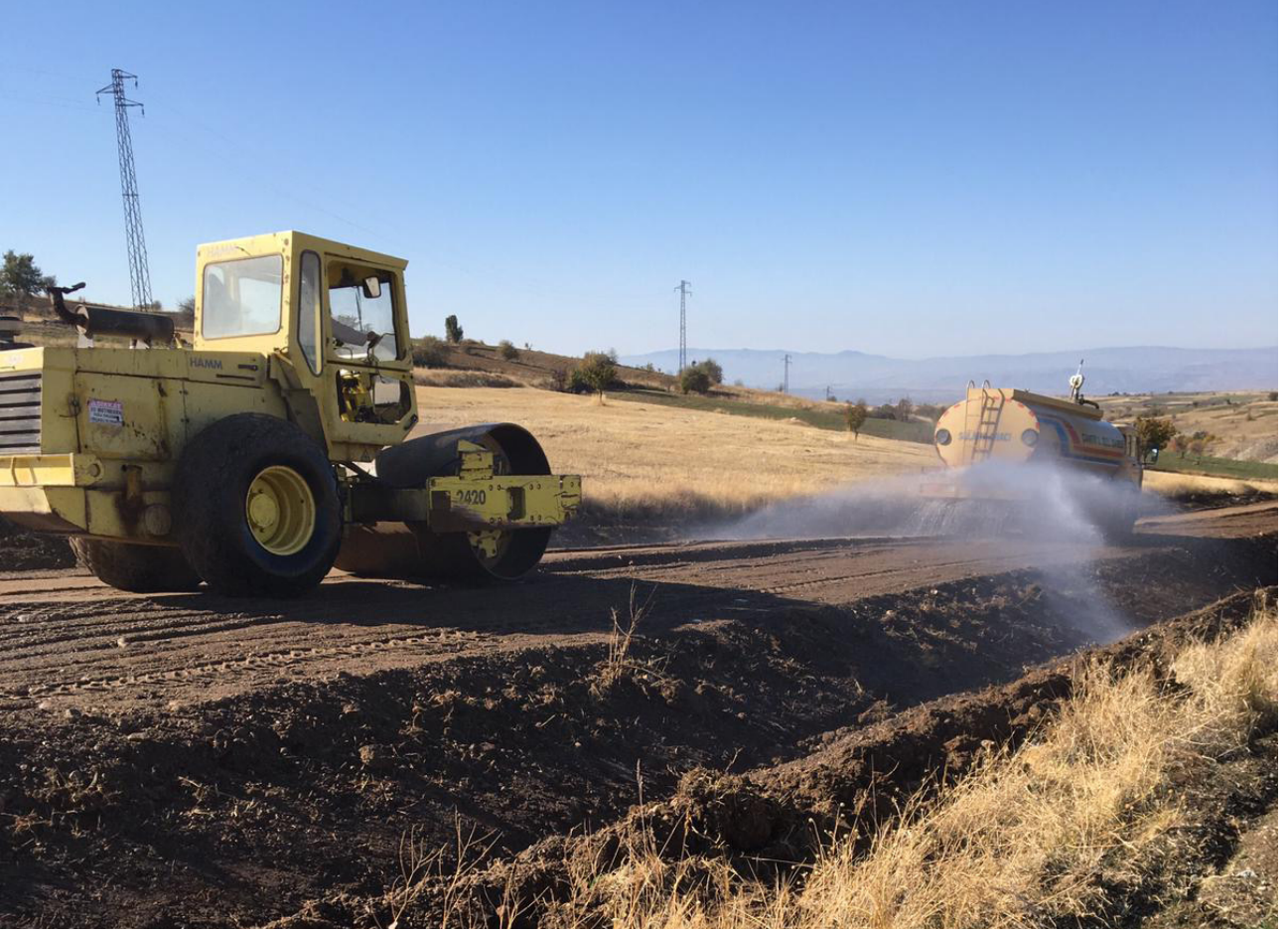
Merkez Karaşeyh - Hamzalı Yolu Malzemeli Bakım
