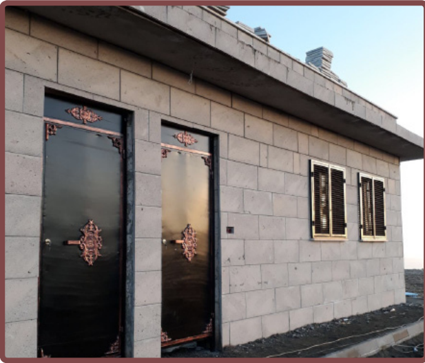
Gözetleme Kulesi Yapım Çalışmaları
