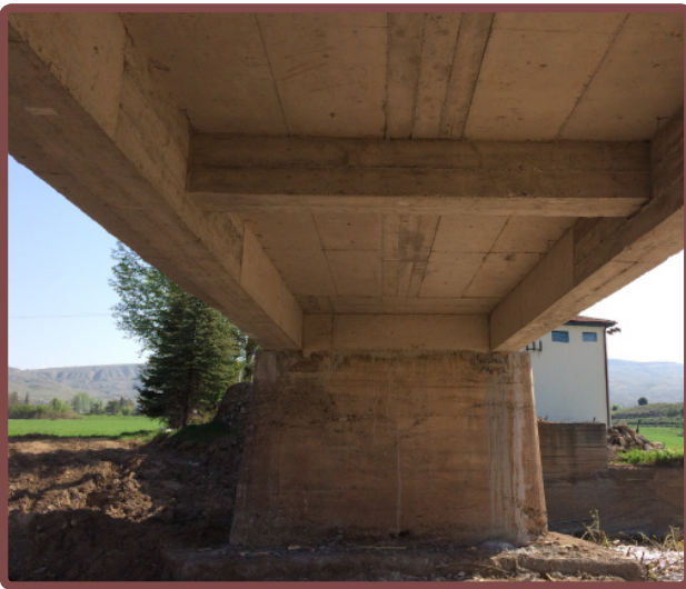
Sanat Yapısı Çalışmaları
