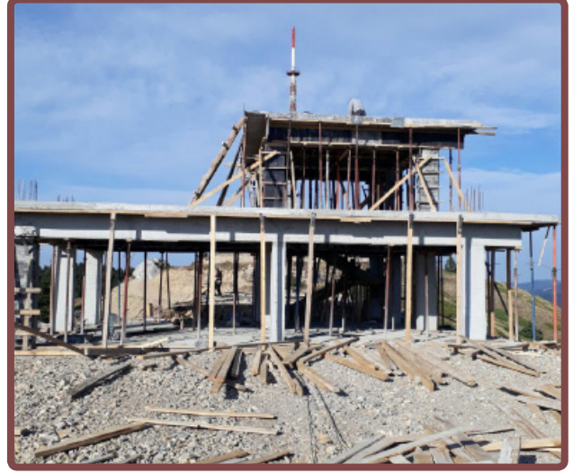
Gözetleme Kulesi Yapım Çalışmaları
