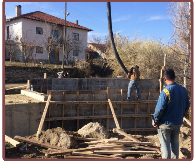
Sanat Yapısı Çalışmaları
