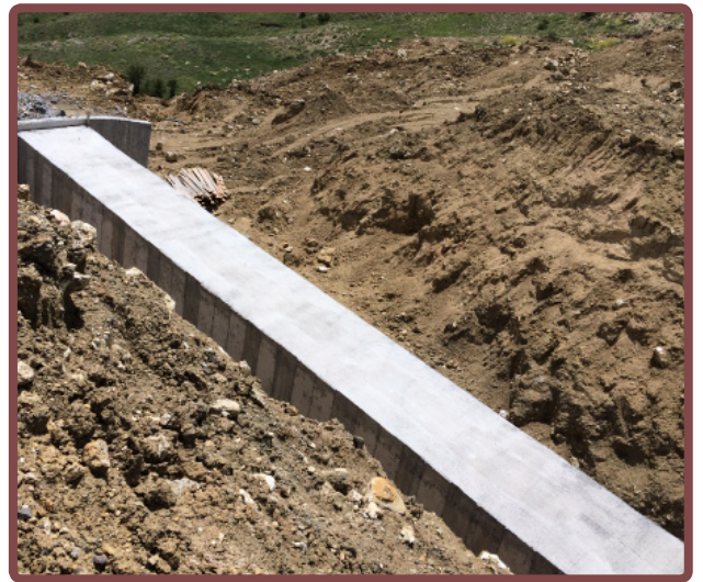
Sanat Yapısı Çalışmaları
