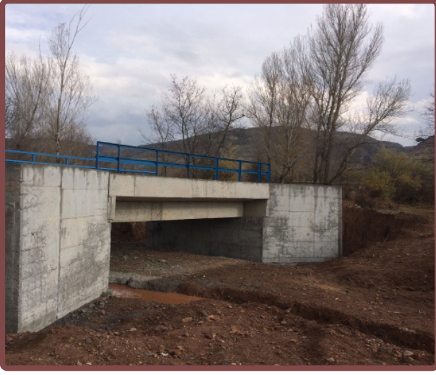
Sanat Yapısı Çalışmaları
