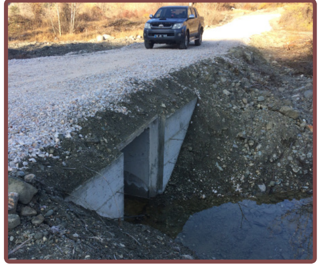
Sanat Yapısı Çalışmaları
