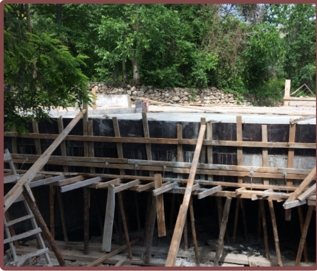
Sanat Yapısı Çalışmaları
