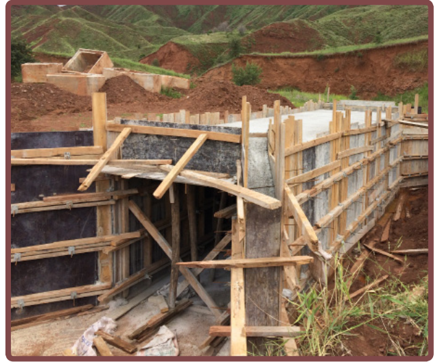
Sanat Yapısı Çalışmaları
