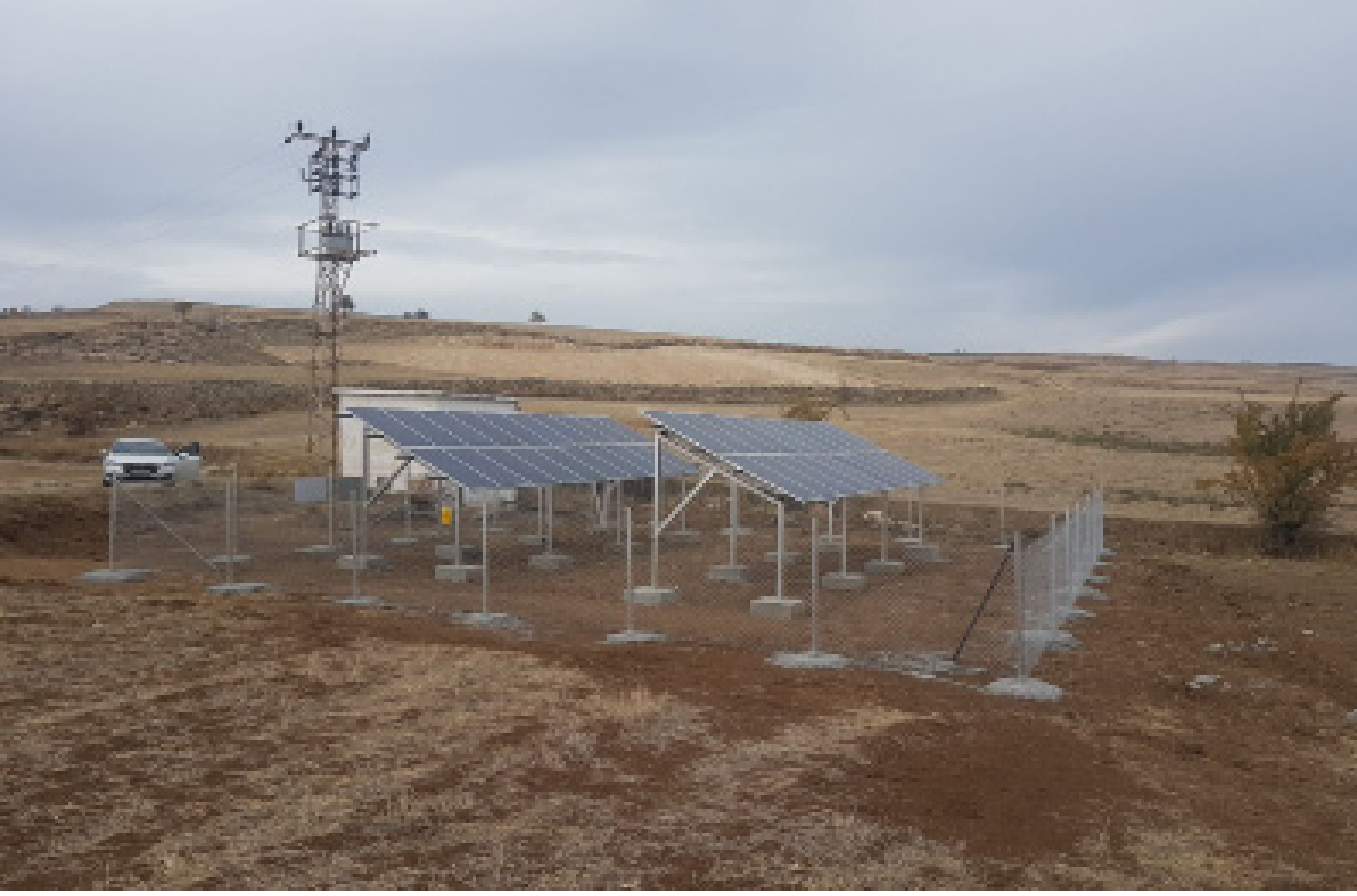
Çağabey Köyü İçme Suyu Tesisi İçin Güneş Enerjisi Kurulumu
