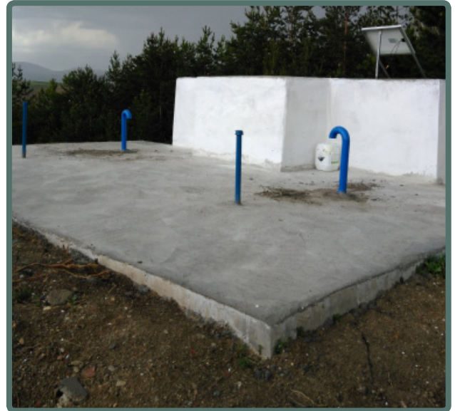
İçmesuyu Deposu Bakım ve Onarımı
