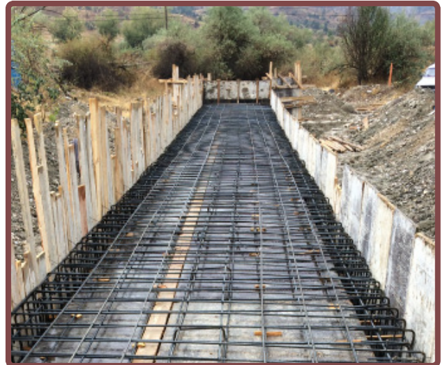
Sanat Yapısı Çalışmaları
