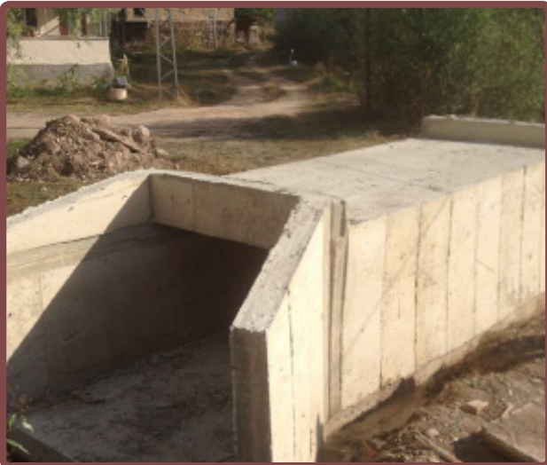
Sanat Yapısı Çalışmaları
