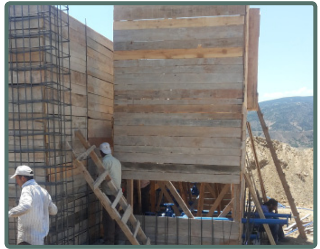
Merkez Akçavakıf Köyü İçmesuyu Deposu Yapımı
