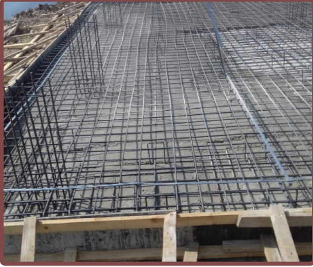
Gözetleme Kulesi Yapım Çalışmaları
