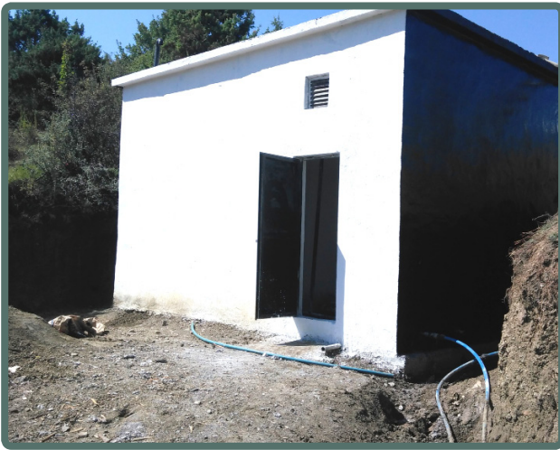
Yapraklı Ayva Köyü İçmesuyu Deposu Onarım
