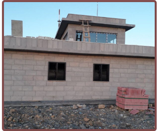
Gözetleme Kulesi Yapım Çalışmaları
