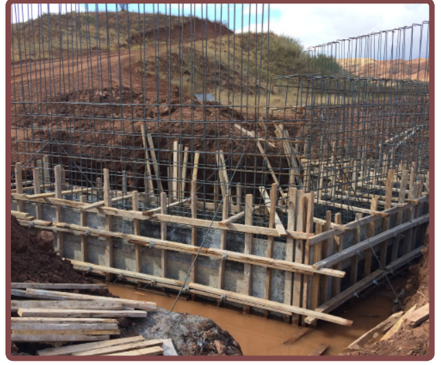
Sanat Yapısı Çalışmaları
