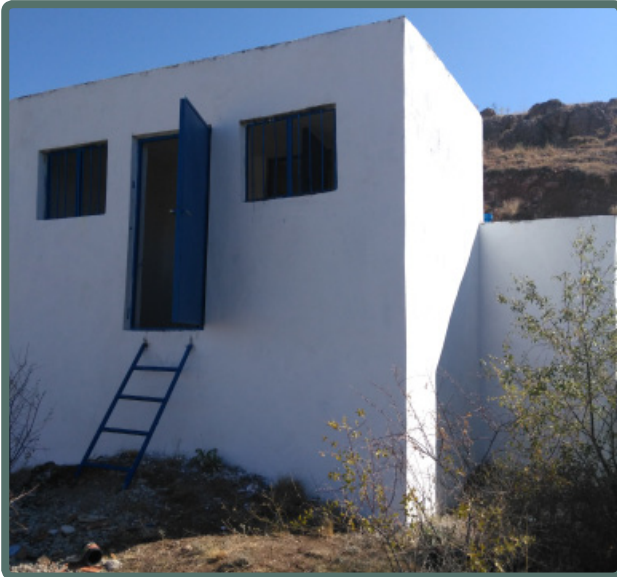
İçmesuyu Deposu Bakım ve Onarımı
