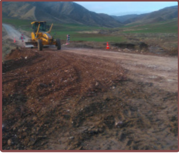
Sanat Yapısı Çalışmaları
