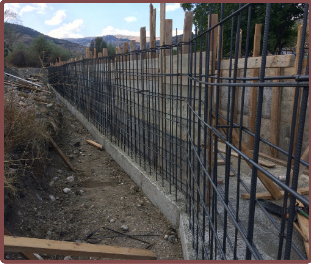
Sanat Yapısı Çalışmaları
